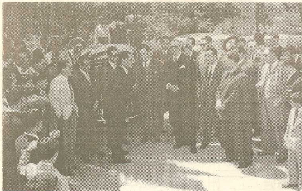
António Barros (na foto a discursar) quando dava carta branca ao Ministro das Obras Públicas, após oferecer os terrenos para a construção da Escola Preparatória (hoje C+S)
